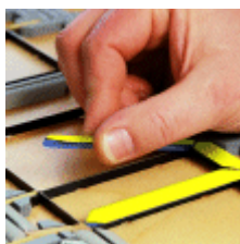
Slika 33: Namestitev žlebilne podloge
