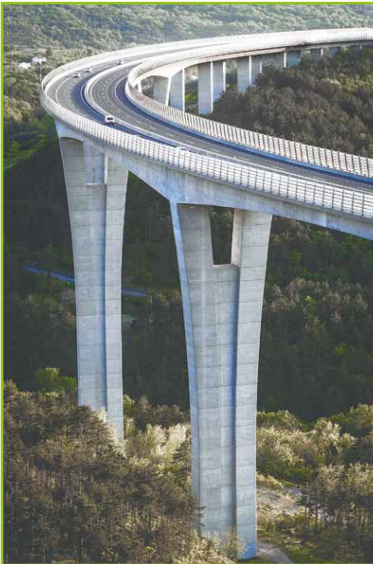
Poseg v naravo; viadukt Črni Kal.
